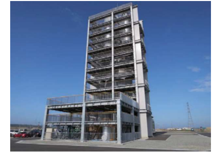
福島ロボットテストフィールド 模擬プラント施設
